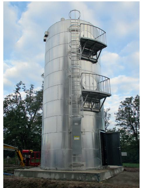
Für die Wasserversorgung eines Truppenübungsplatzes in Ostdeutschland wurde ein HydroSystemTower® mit 2 x 30 m<sup>3</sup> Volumen, integrierter Druckerhöhungsanlage, umfangreicher Installation und Steuerungsanlage gefertigt, versetzt und in Betrieb genommen.
