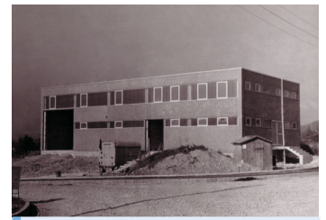
1973 Firmengebäude in Oberseschach im Bau
