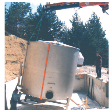
Bild 3: Montage des Hydro-Clear
