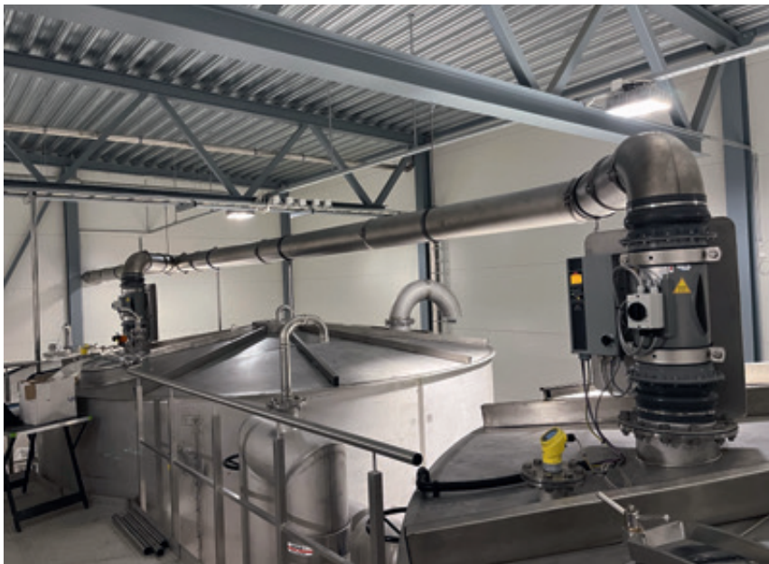
Abb. 9 Geregelte Filterentlüftung
