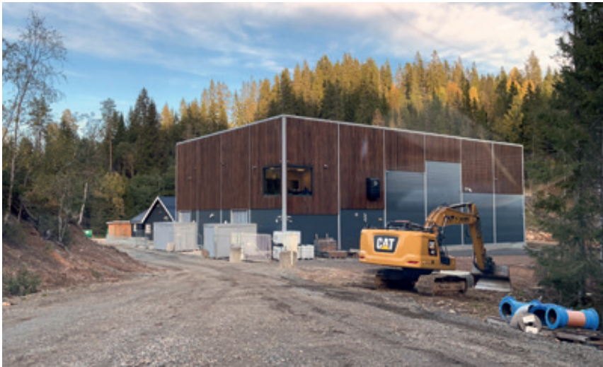
Abb. 2 Neubau mit Bestand im Hintergrund
