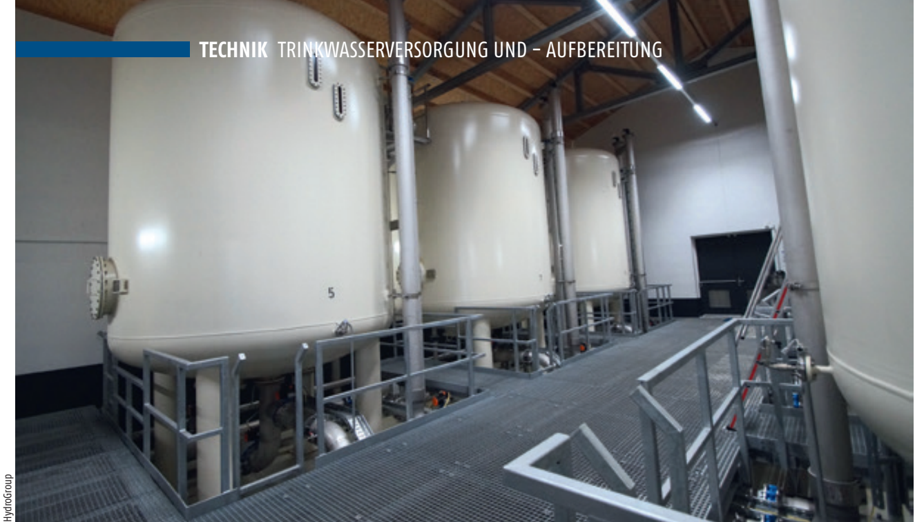
Abb. 1 – Neue Druckfilteranlage mit sechs Filterkesseln
