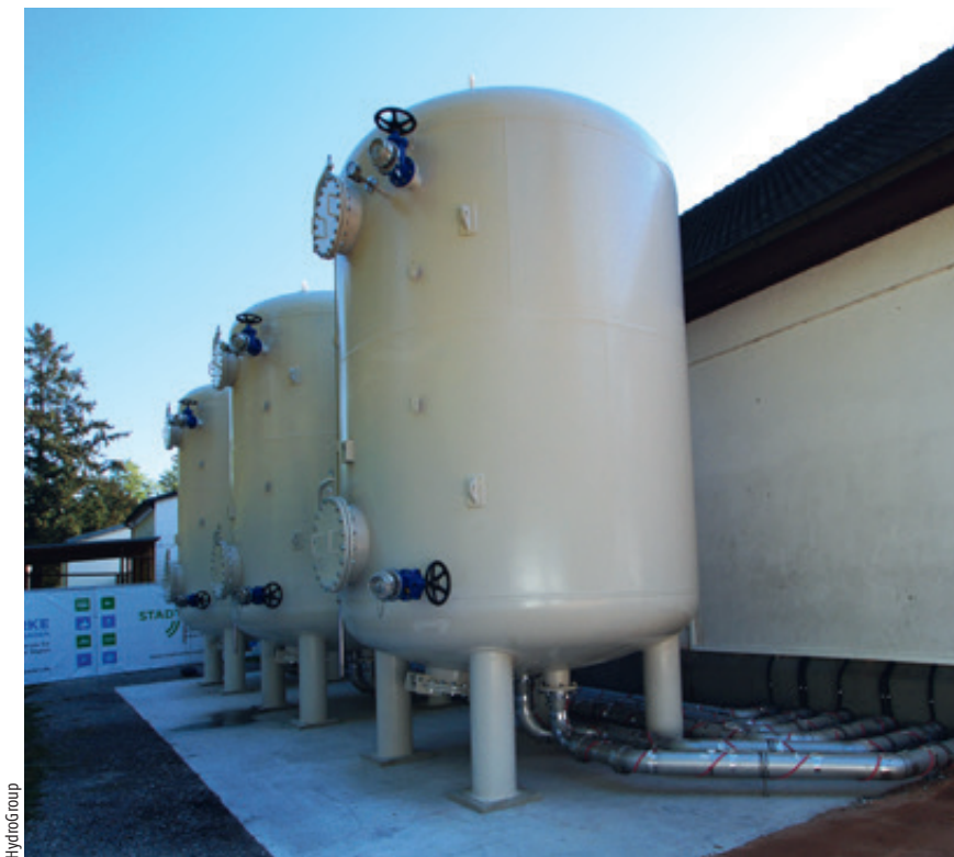
Abb. 6 – Aktivkohlefilter zur Retentataufbereitung
