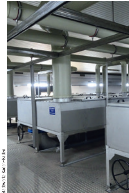
Abb. 3 – Die insgesamt drei Flachbettbelüfter weisen eine Gesamtdurchsatzmenge von 1.350 m 3 pro Stunde auf.
