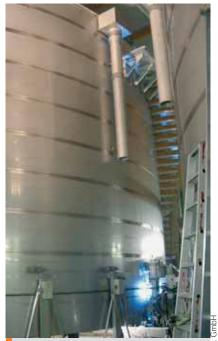
Abb. 3: Zwei Edelstahlbehälter mit je 1.250 m³ Speicherkapazität werden in Zukunft die Trinkwasserversorgung des Marktes Grassau sicherstellen.
