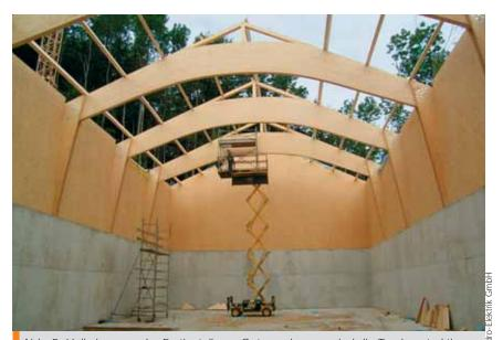
Abb. 5: Halle kurz vor der Fertigstellung. Gut zu erkennen sind die Tragkonstruktion sowie die OSB-Wandverkleidung.
