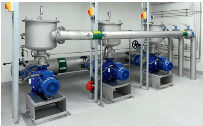
Abb. 4 – Ozonmischsystem mit Venturi-Injektor für 3 x 1 kg/h
