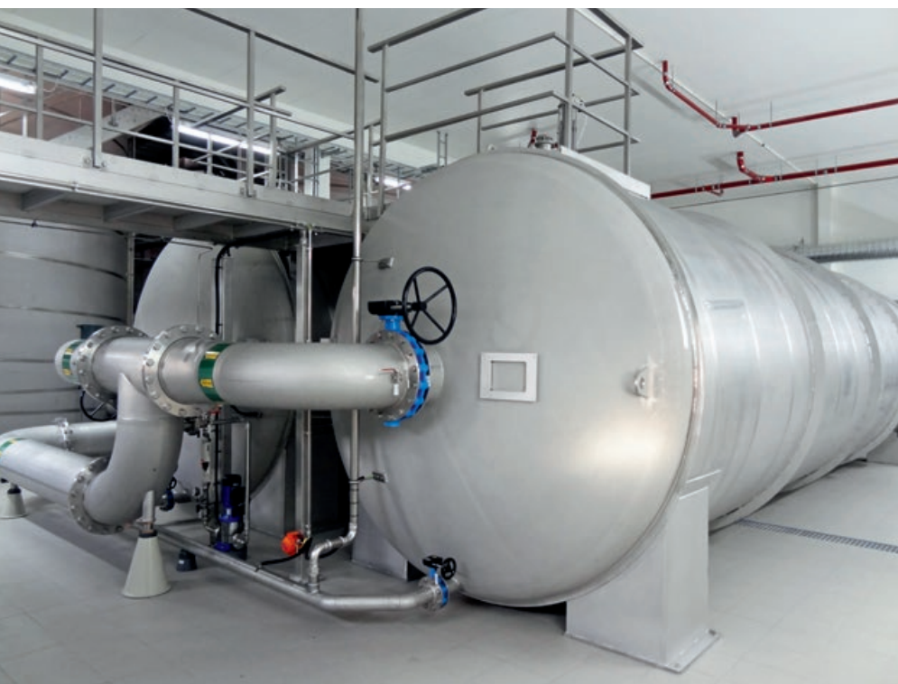
Abb. 5 – Kontakt- und Reaktionsbehälter aus Edelstahl
