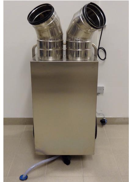
Bei hohen Gebäuden wie Edelstahlhochbehältern sind Geräte mit Luftaustritt nach oben über justierbare Rohre bzw. Bogen zur Einstellung einer gerichteten Strömung bevorzugt zu verwenden. Diese Entfeuchter können mittig aufgestellt und idealerweise mittels Taupunktfühler betrieben werden.
