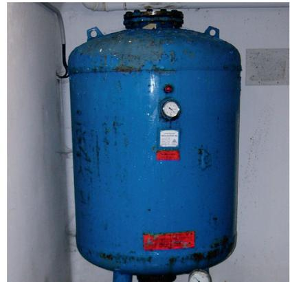
Abb.2: Korrosion und Rost
