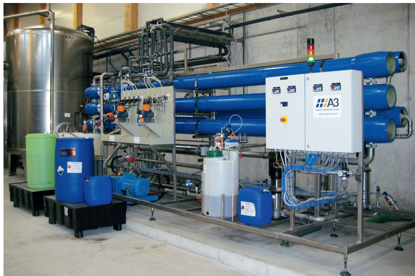
Permeatgestufte Umkehrosmoseanlage
